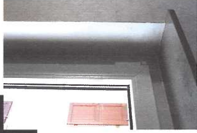
Verfugung mit PU-Dichtstoff, den sie jederzeit überstreichen können
