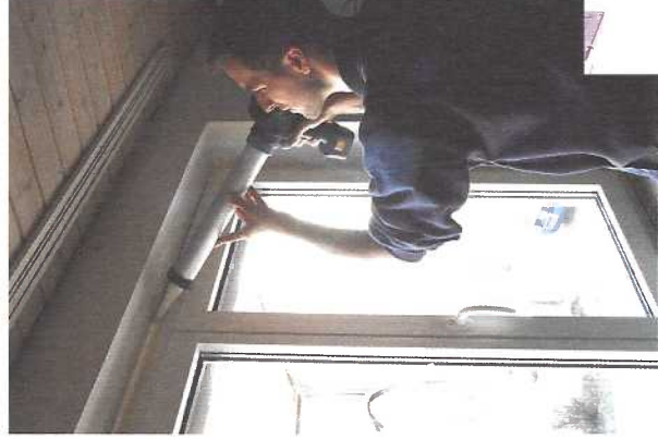
Verfugung mit PU-Dichtstoff, den sie jederzeit überstreichen können
